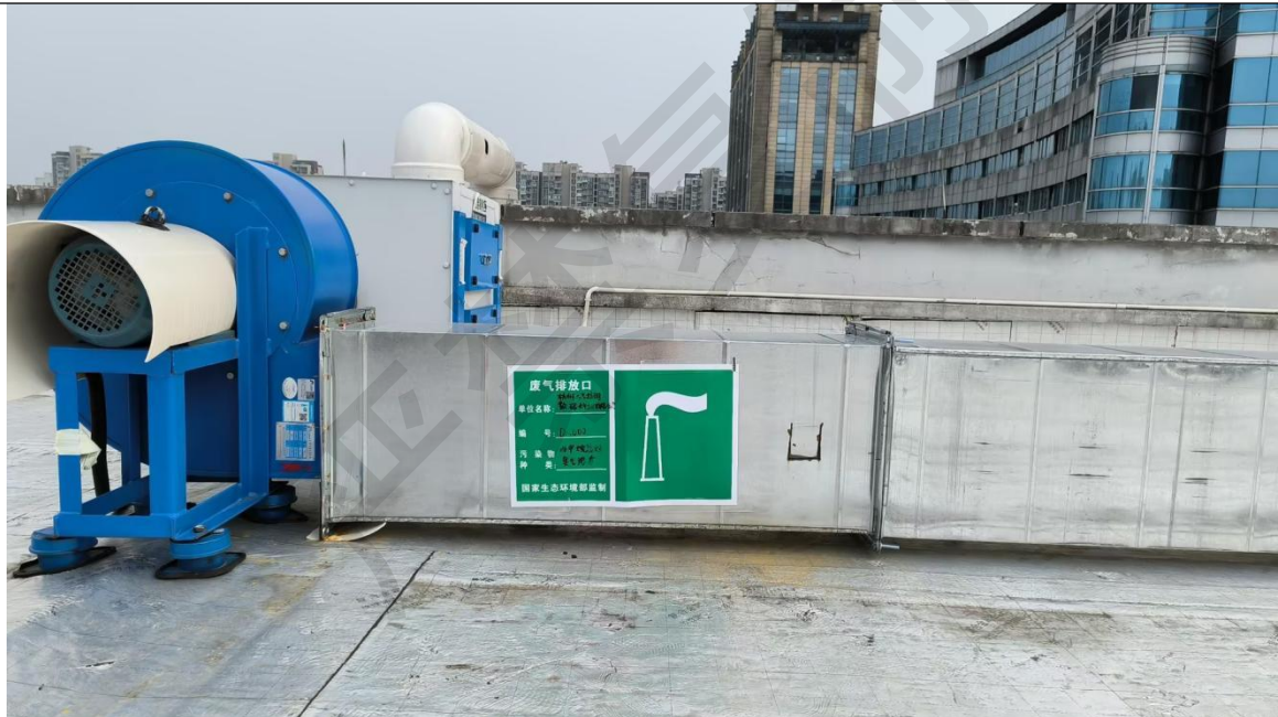
打印测试废气、打印清洗废气、固化废气处理设施及排放口
