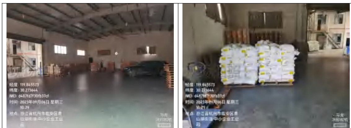
图 4.3-1 仓库内部现状
