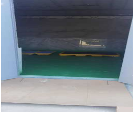
图3-5 危险废物暂存间
